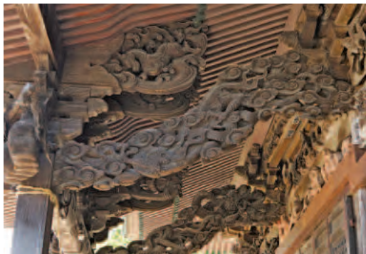
拝殿の虹梁(こうりょう)には渦巻く波の上を走る麒麟(きりん)が彫刻されています。
