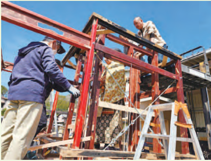
山車修繕作業(電線の下を通れるよう人形を上下できる昇降機の取付け)
