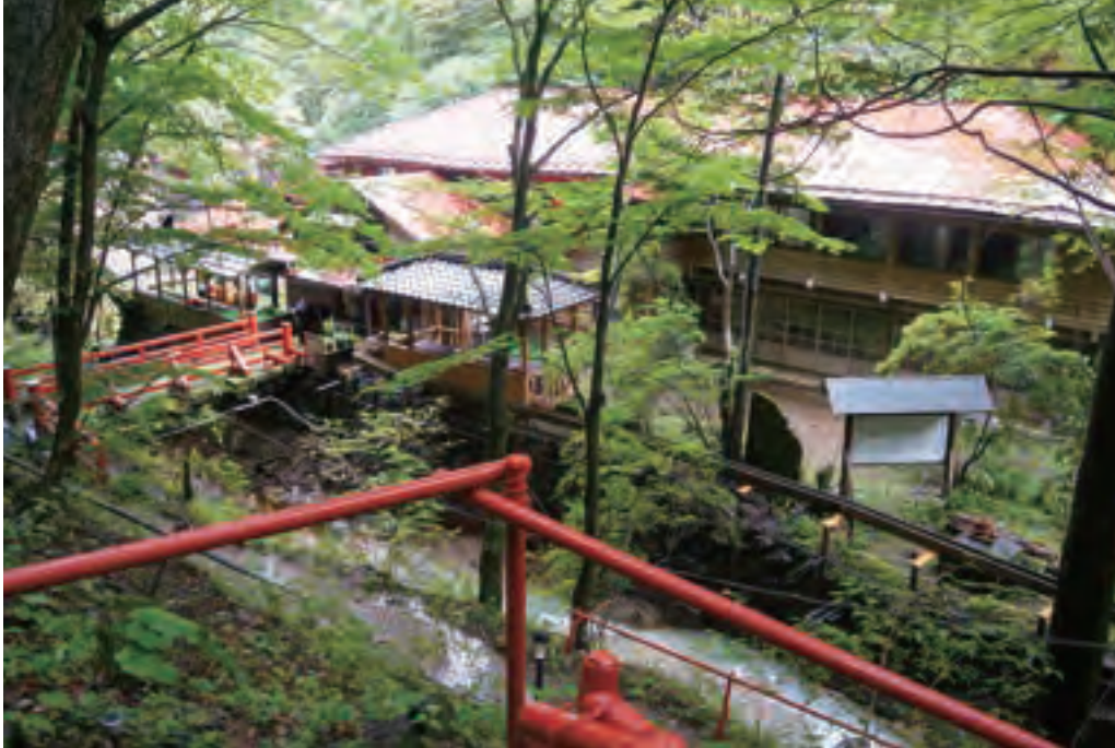
木造二階建の部分は明治16年に建てられました。
