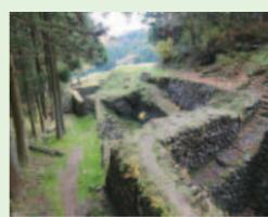
**荒船風穴**(甘楽郡下仁田町) / 国内最大規模の蚕種(蚕の卵)の貯蔵施設。岩山の底で放出される冷気を利用し孵化の時期を調整することで、春にしかできなかった養蚕が1年に複数回できるようになり繭の生産量の増大、生糸の増産につながりました。取引先は全国に及びました。
